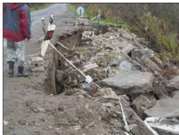
Рис. 4. Смещение засыпанного материала от автомобильного полотна на 0,5 м вниз по склону (30 сентября 2014 г.) (с. Лойно Верхнекамского района Кировской области)
