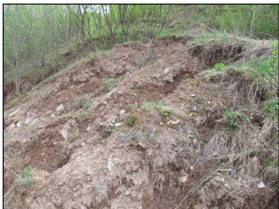
Рис. 4.7.9. Промоины в склоне р. Вятка в районе мемориала «Вечный огонь» г. Кирово-Чепецк в 2014 году
