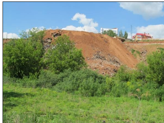
Рис. 4.7.1, 4.7.2. Отсыпка строительного мусора, кирпичей, досок, грунта, песка с образованием нескольких террас на склоне р. Вятка в г. Кирове
