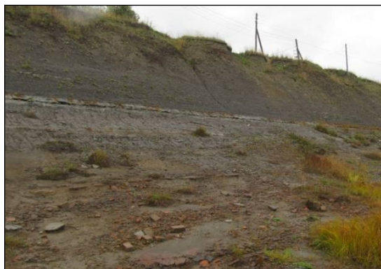
Рис. 4.7.5. Склон р. Кама и ЛЭП вдоль бровки склона
