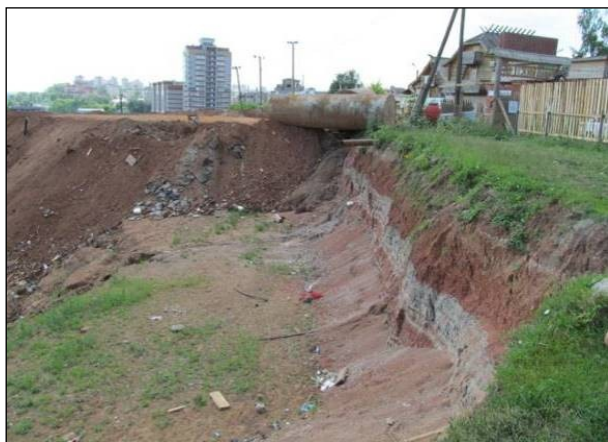
Рис. 4.7.3. Подрезка в верхней части склона р. Вятка
