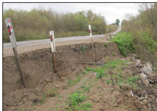
Рис. 4.7.8. Смещение засыпанного строительного материала вниз по склону р. Кама на месте произошедшего оползня
