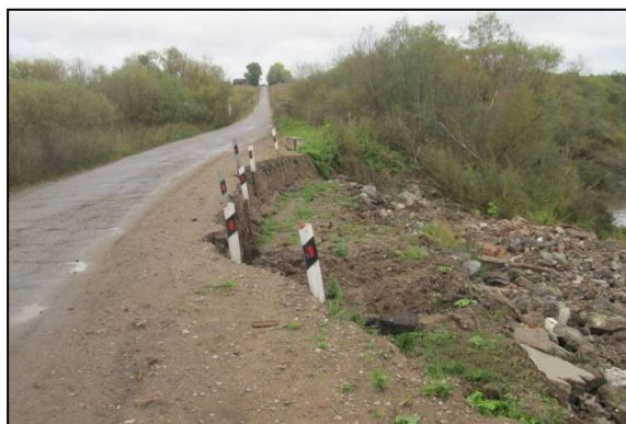
Рис. 4.7.7. Аварийный участок автомобильной дороги в районе с. Лойно
