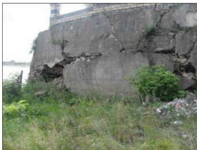
**Рис. 4. Разрушение подпорной стенки у речного вокзала г. Кирова**
