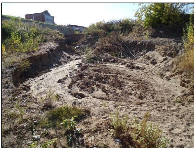
Рис. 12.12. Промоина в грунтовой дороге с западной стороны берегоукрепления, г. Вятские Поляны, Кировская область
