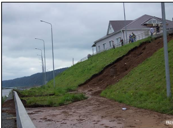
Рис. 12.10. Смыв ливневыми водами спланированного участка выше берегоукрепления на р. Вятка, г. Вятские Поляны, Кировская область
