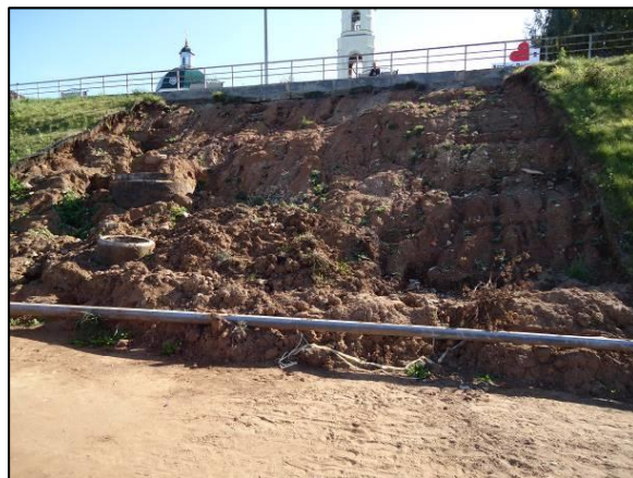
Рис. 12.11. Сползший спланированный участок выше берегоукрепления на р. Вятка, г. Вятские Поляны, Кировская область
