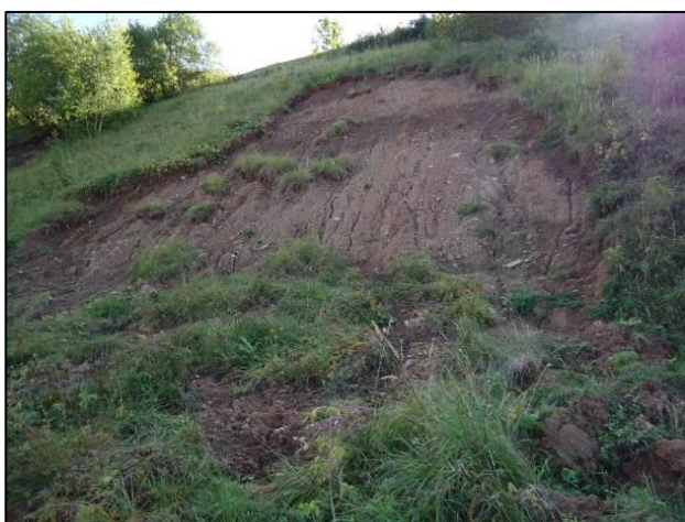
Рис. 12.14. Оползень течения № 2, г. Вятские Поляны, Кировская область
