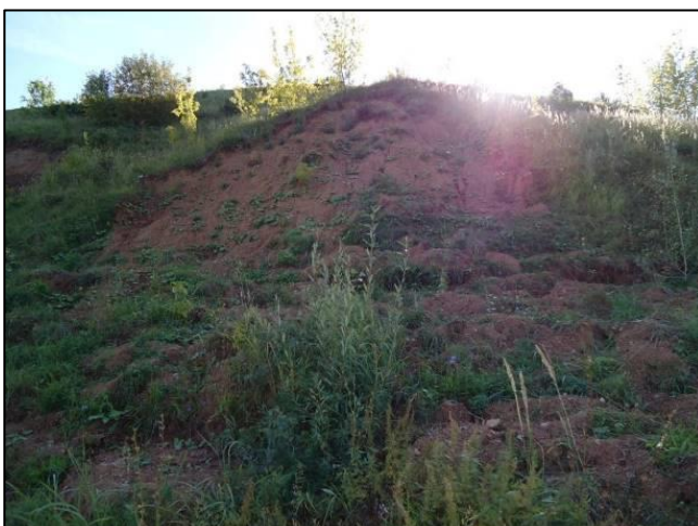
Рис. 12.13. Оползень течения № 1, г. Вятские Поляны, Кировская область
