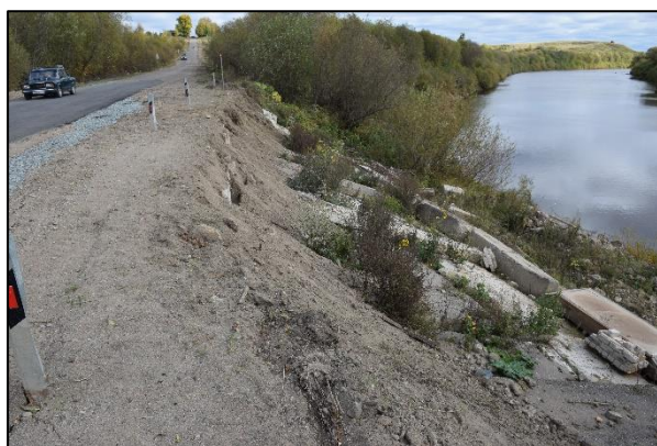
Рис. 12.15. Ремонт аварийного участка автомобильной дороги в районе с. Лойно Верхнекамского района
